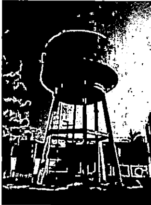
Figura 5.9 – Reservatório para Lavagem dos Filtros
