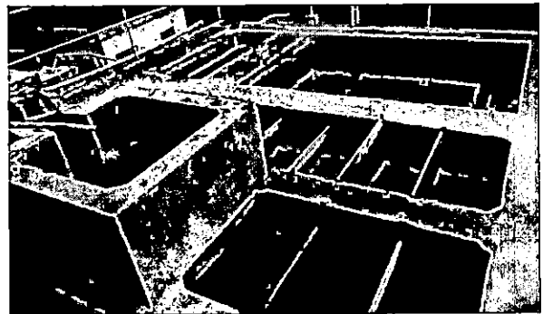
Figura 5.44 – Vista Floculador e Decantador ETA Garrafão
