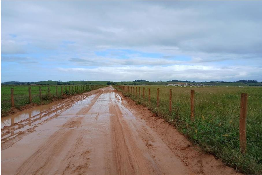
***Leito da estrada totalmente tomado por lama devido a falta de escoamento lateral***
